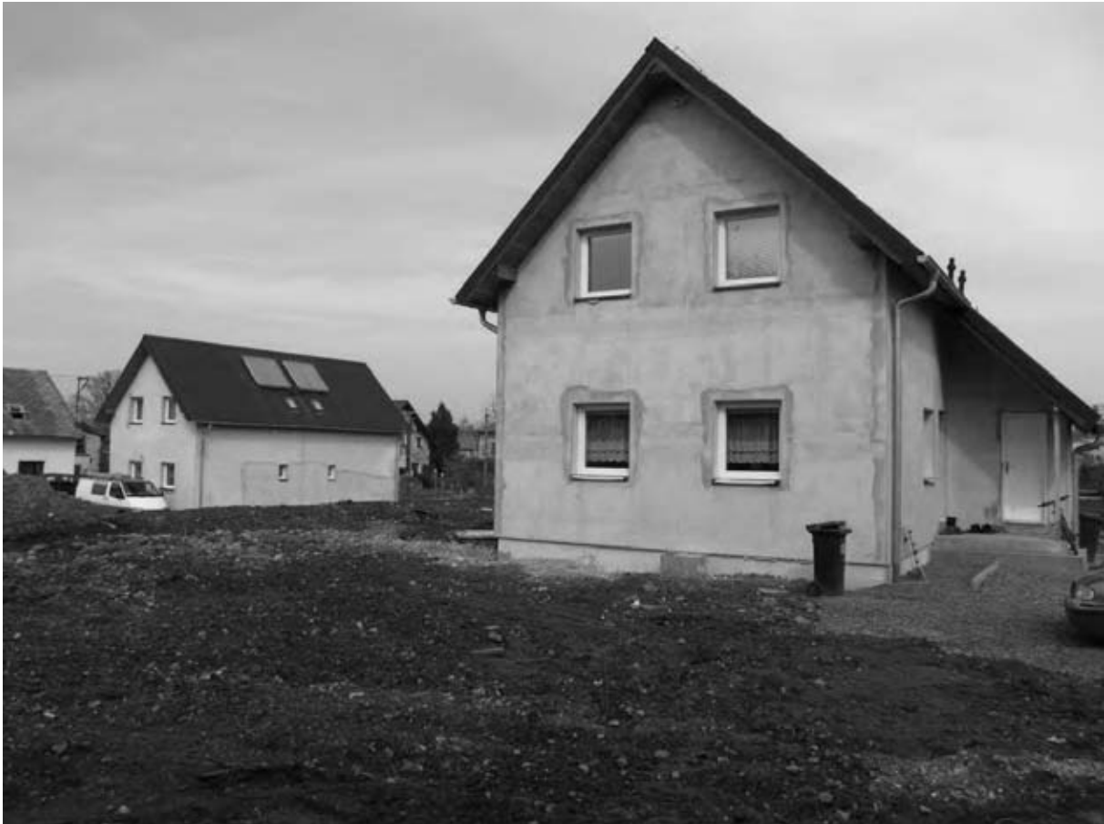
Obr. 10 - Povodňový domek Hrádek nad Nisou z materiálu Flexibuild
