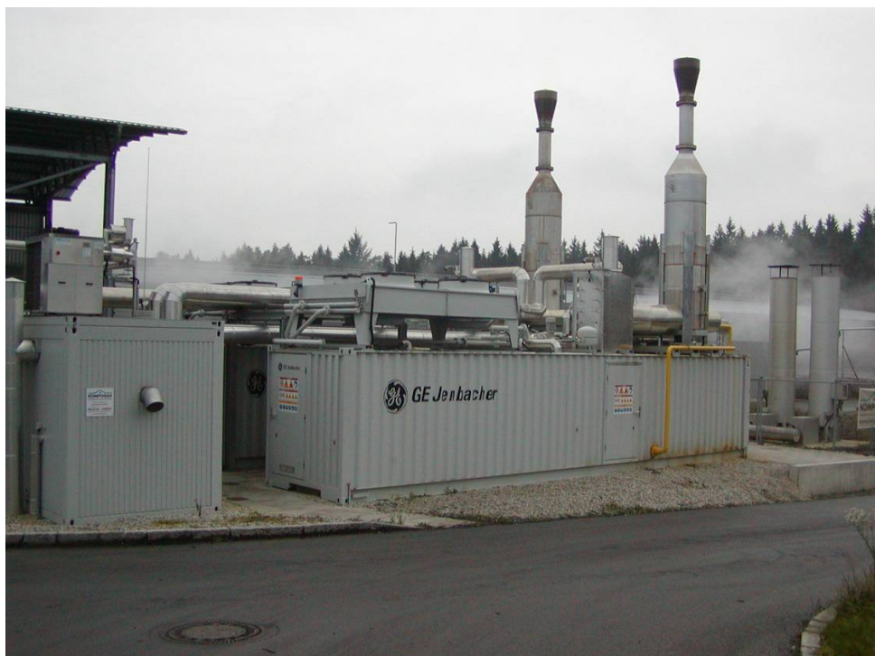
Foto 2: BPS u Passau. Dvě kogenerační jednotky jsou významným energetickým zdrojem. Každá z nich má elektrický výkon 836 kW.
