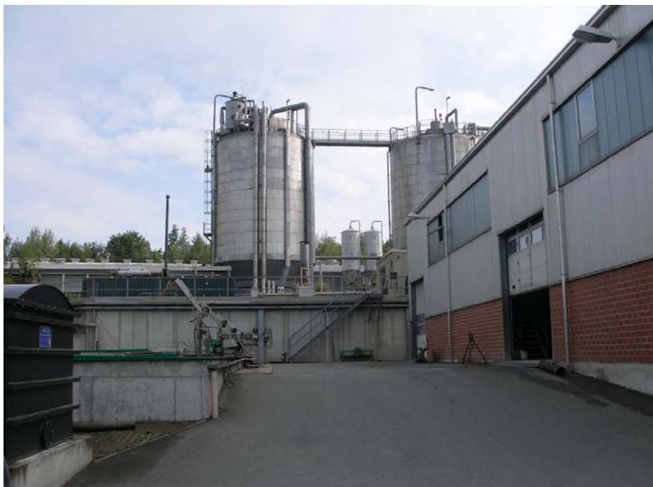
Foto 1: Dva ze tří fermentorů BPS u Plauen. Každý z nich má objem 750 m 3 . V pravé části je hala, kde probíhá mechanické dotřídění bioodpadů z domácností.
